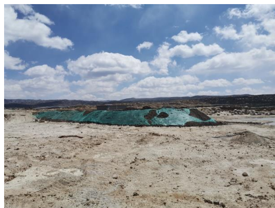
照片 4.3-4 表土苫盖
