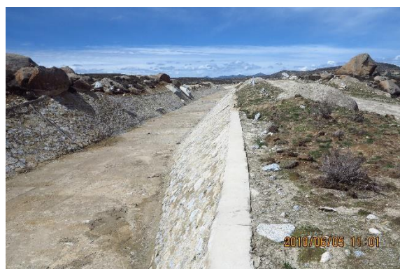
工程措施、临时措施巡查
