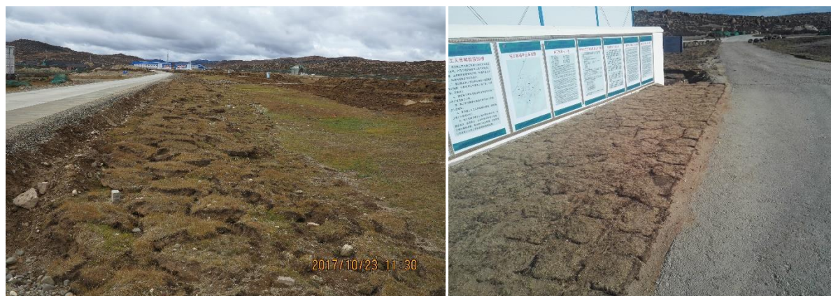
植物措施现场巡查监测
