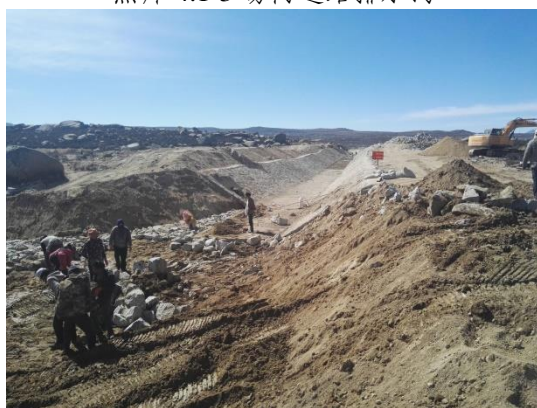
照片 4.1-5 导流渠出口铺砌
