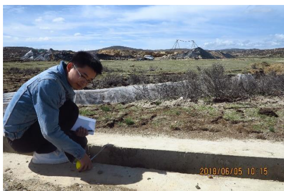
工程措施实地量测
