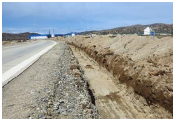
照片 4.3-2 临时排水沟
