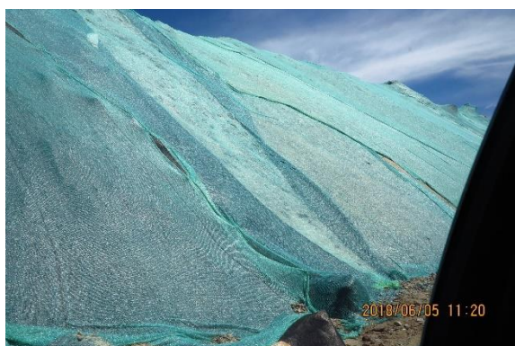
工程措施现场抽查
