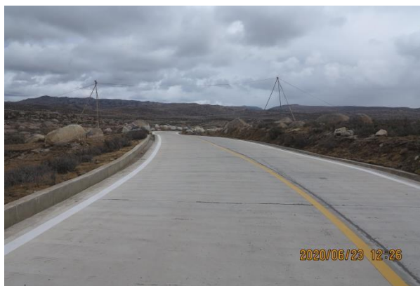
照片 4.1-3 场内道路排水沟
