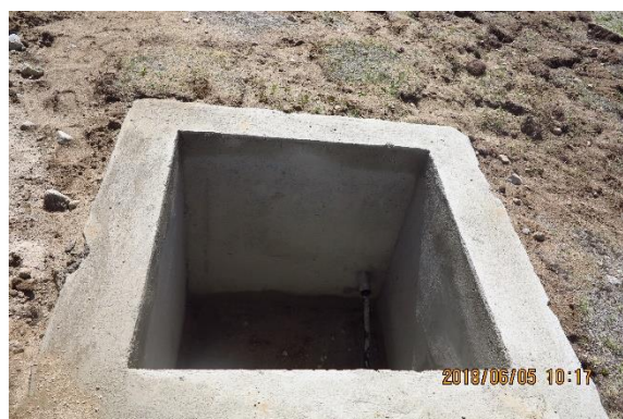
工程措施实施过程现场监测
