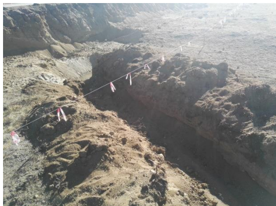
照片 4.3-1 临时排水沟
